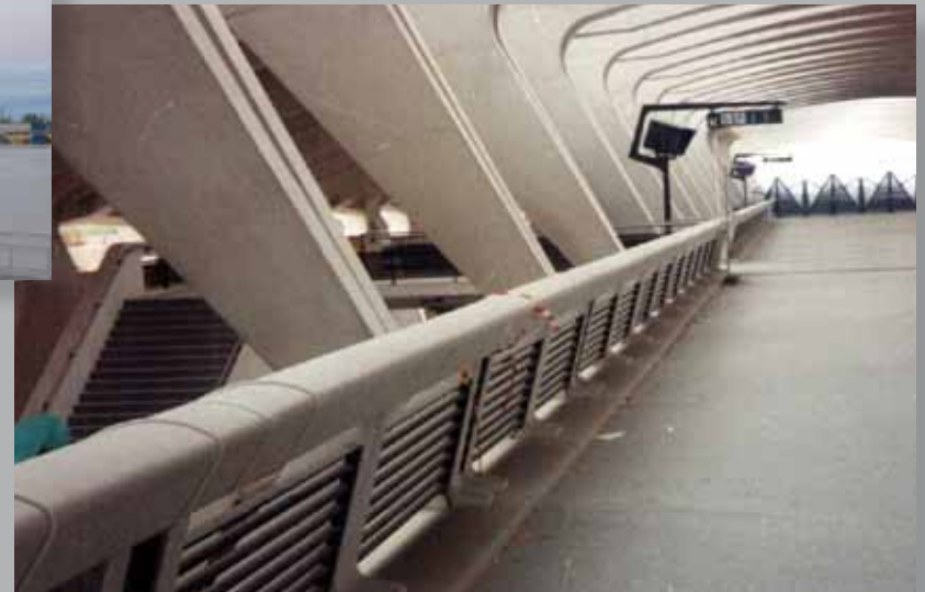
Gare TGV Saint-Exupéry – Calatrava Architecte
