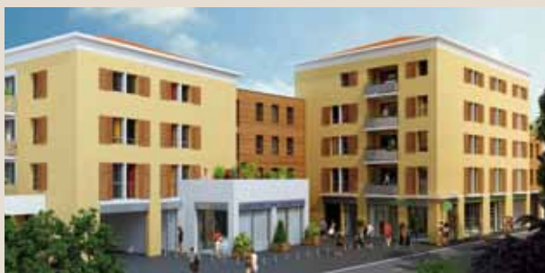
« Suzanna » à Lozanne (69) Architecte Unanime
